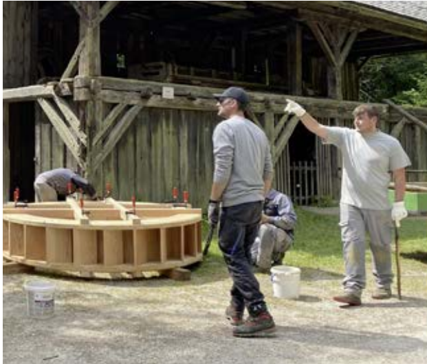
Zwei heiße Eisenreifen müssen auf das neu gezimmerte Wasserrad aufgezogen werden, bevor es seine kraftvolle Arbeit an der Mühle leisten kann.
